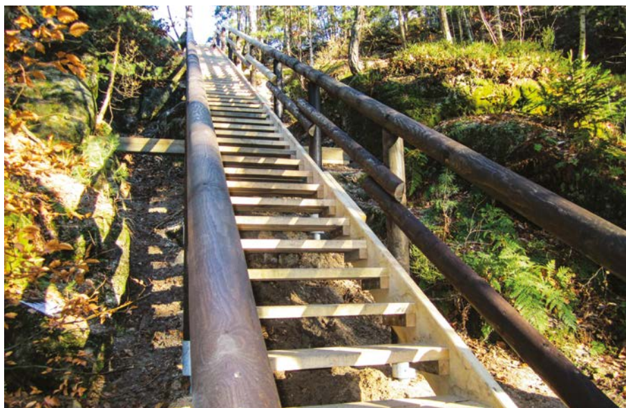
Dřevěné schodiště CHKO Kokořínsko – Máchův kraj, schodiště na skalní útvar Pokličky, foto: Petr Bláha
