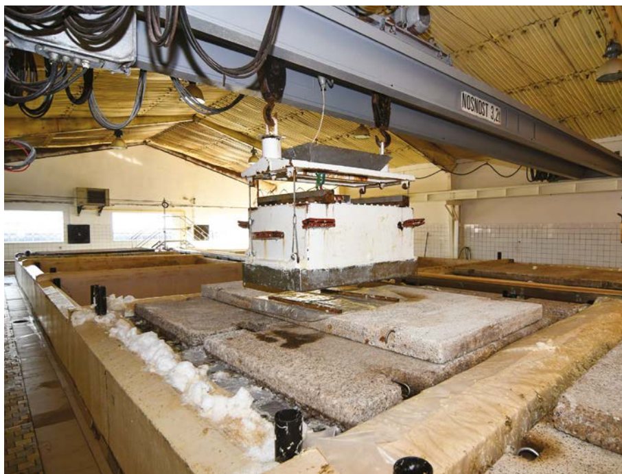
Kvasný bazén uzavřený betonovou deskou
