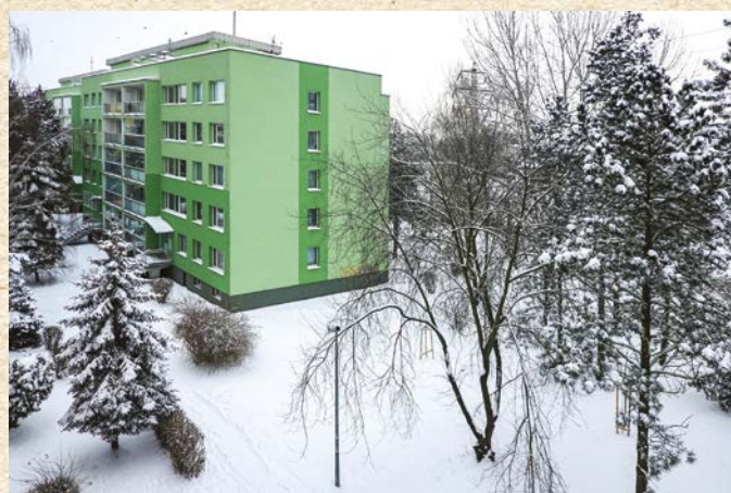
I atmosféru sídlišť oživovaly jen pestré nátěry panelových domů
